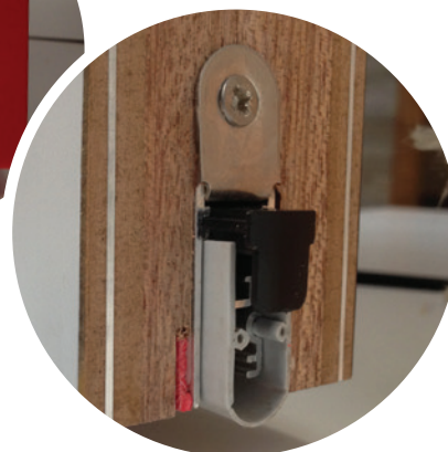
Détail: seuil tombant automatique.
